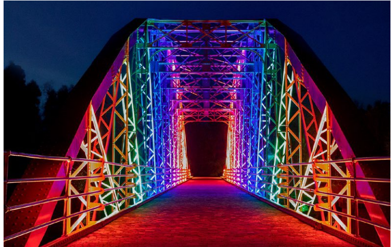
Puente de los Remedios, Villafranca de Cordoba 2022
